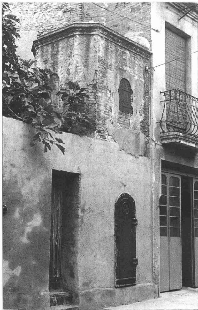
FOTOGRAFIA 3. Caseta on es situà el repartidor d'aigües de la mina de Ribatallada, al carrer del Convent. (Foto: Gaspar Sarradell/ Col·lecció CASSA).
