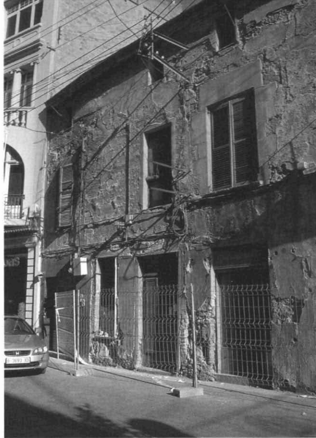
Fotografia 7. Façana del carrer de Gràcia. Al fons s'observa l'ampliació de 1846. S'observen, a primer terme, les finestres de la primera planta de la construcció de 1602. La primera finestra té emmarcaments de pedra que es devien haver recol·locat, provinents de la façana sud (desmuntada l'any 1867). Autora: Gemma Caballé.
