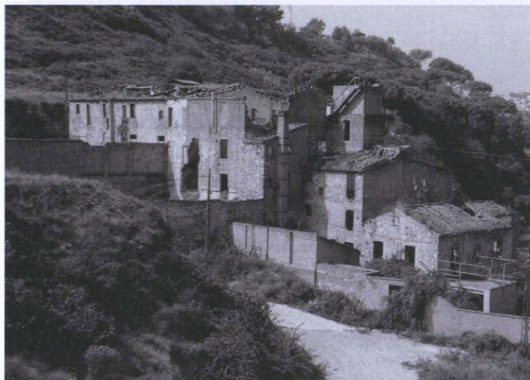
Fotografia 3. Molí d'en Torrella des del pont de la Salut, podem observar, malgrat el mal estat, els diferents edificis o cossos que componen aquest complex edificí, any 1997. Autor: Josep M. Masagué.
