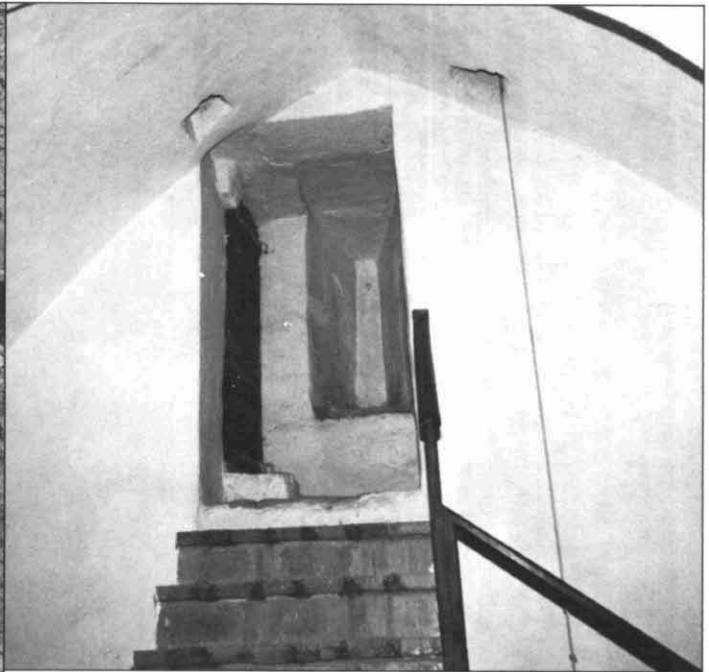
FOTOGRAFIA 15. Planta del Cor. Arc apuntat.
