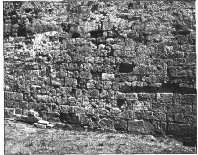
FOTOGRAFIA 4. Façana de ponent. Base del campanar. Parament d'Opus Vittattum sense sospedrar.
