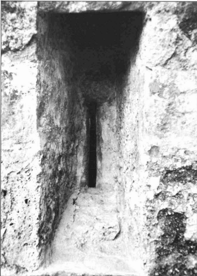
FOTOGRAFIA 10. Detall de la finestra de l'absidiola. Cara interior.
