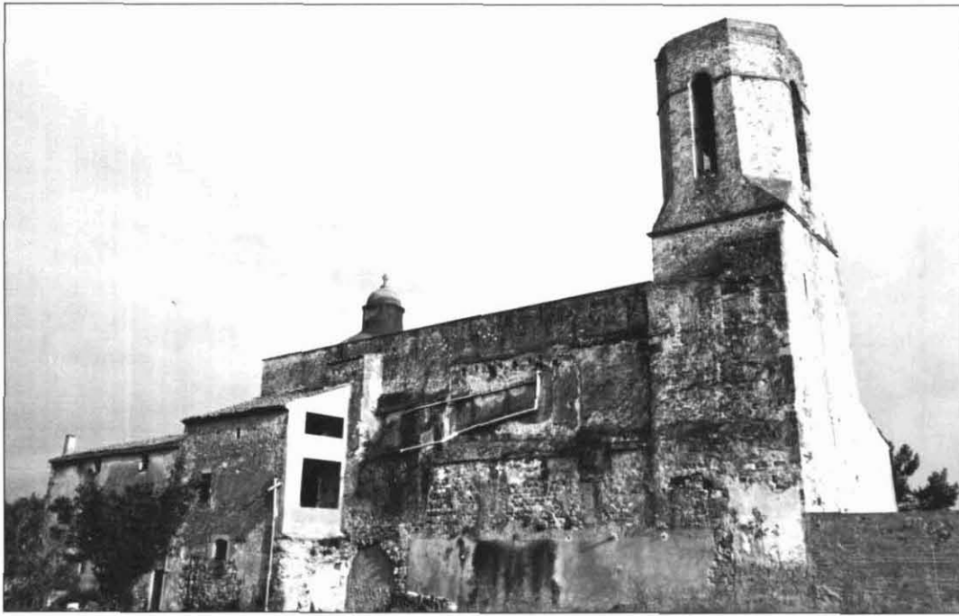
FOTOGRAFIA 8. Murs de tramuntana on hi ha la paret i l'absidiola laterals pre-romàniques.
