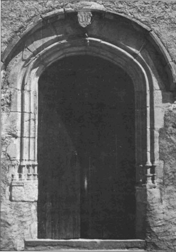
FOTOGRAFIA 14. Façana de migdia. Portal.
