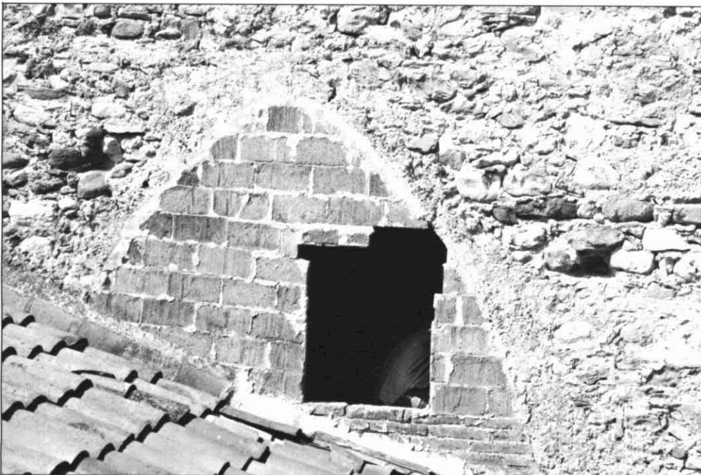
FOTOGRAFIA 17. Primer pis del campanar. Arc cec de la cara nord.
