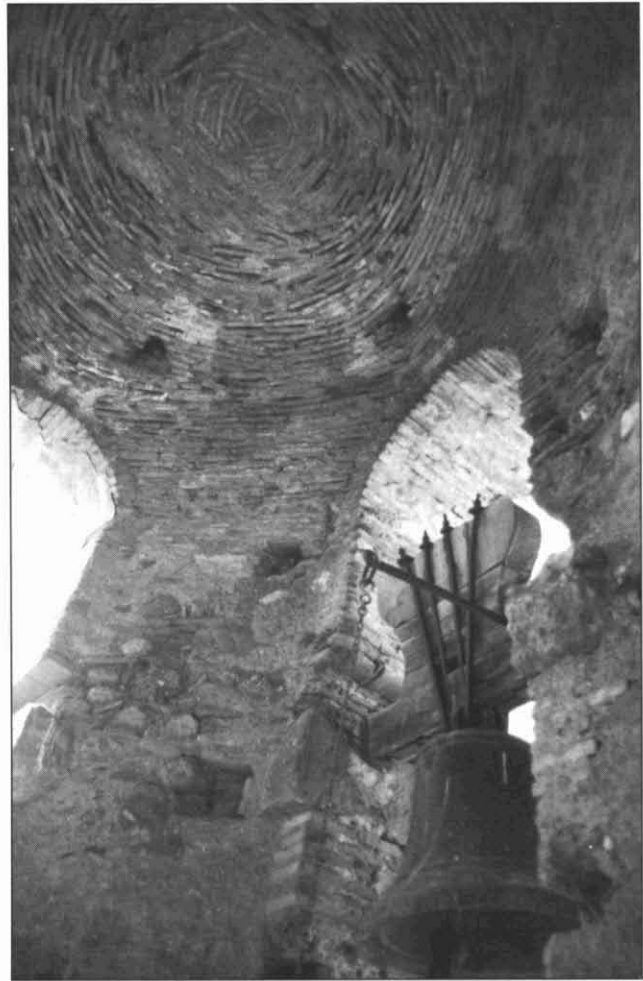
FOTOGRAFIA 21. Volta de l'interior del campanar.
