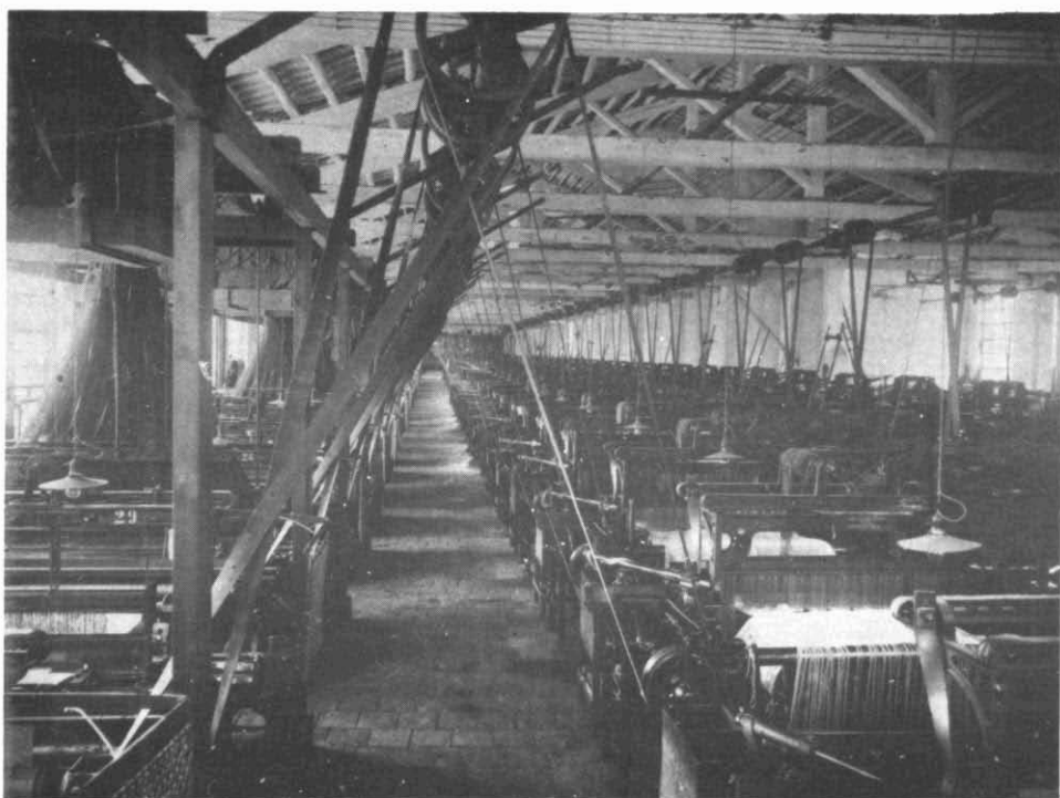
Interior d'una nau de telers a Cal Molins, vapor construït el 1876. La mecanització del tissatge es va accelerar entre 1875 i 1883. En la fotografia pot observar-se la disposició dels embarrats que donaven moviment als telers.
