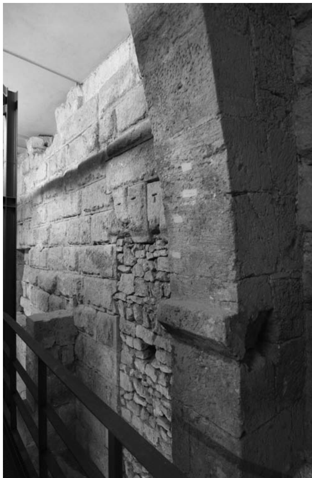
Detall de l'arc de la gran sala del segle XII recolzada al mur del temenos , i d'una de les fenestrae , convertida en porta medieval i paredada en construir-se la galeria del Claustre.
