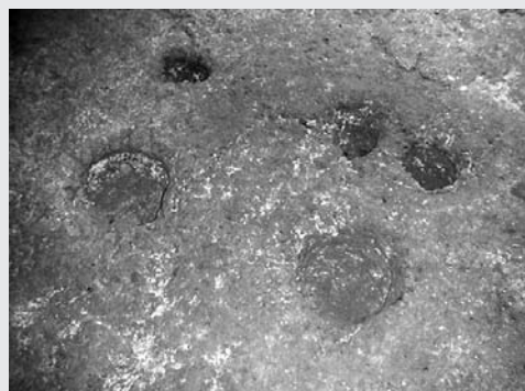
Perforacions al paviment d' opus signinum de la cisterna de l'antiguitat tardana per instal·lar bancs de treball, en aprofitar-la com a cuina.
