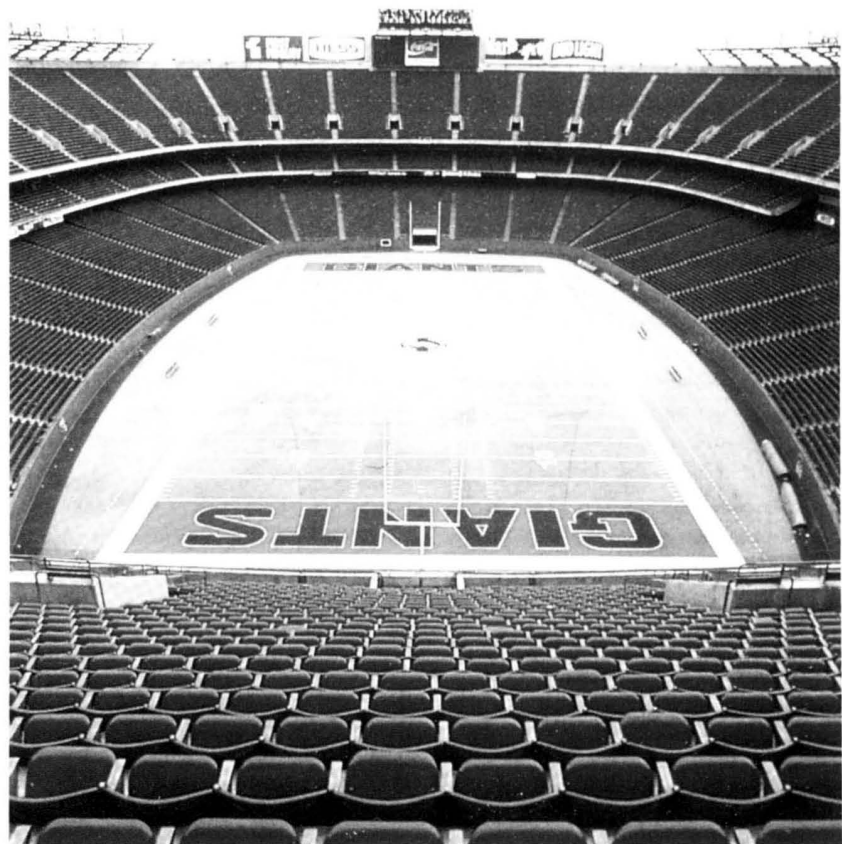
Figura 2. L'estadi dels Gegants, a Nova York, seu d'una de les semifinals del Campionat Mundial de Futbol del 1994. L'estadi dels Gegants és una mostra clara d'instal·lació esportiva pròpia de la tendència racionalitzadora. Res no queda a l'atzar i tot està pensat en termes de funcionalitat i racionalitat
