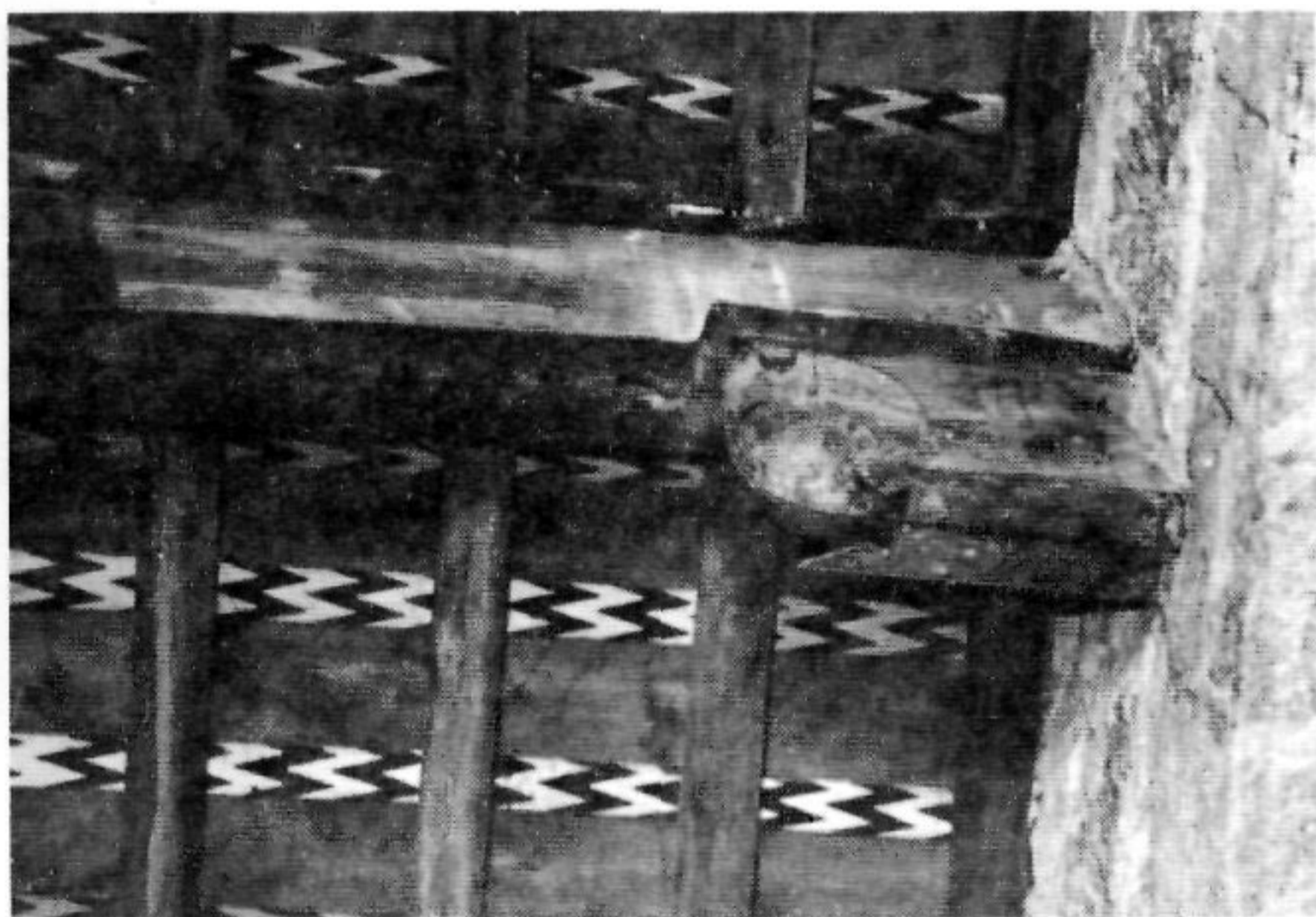
Mènsula acoblada, suportant un cap de biga. Per damunt, s'aprecia l'entramat de biguetes i l'empostissat.
