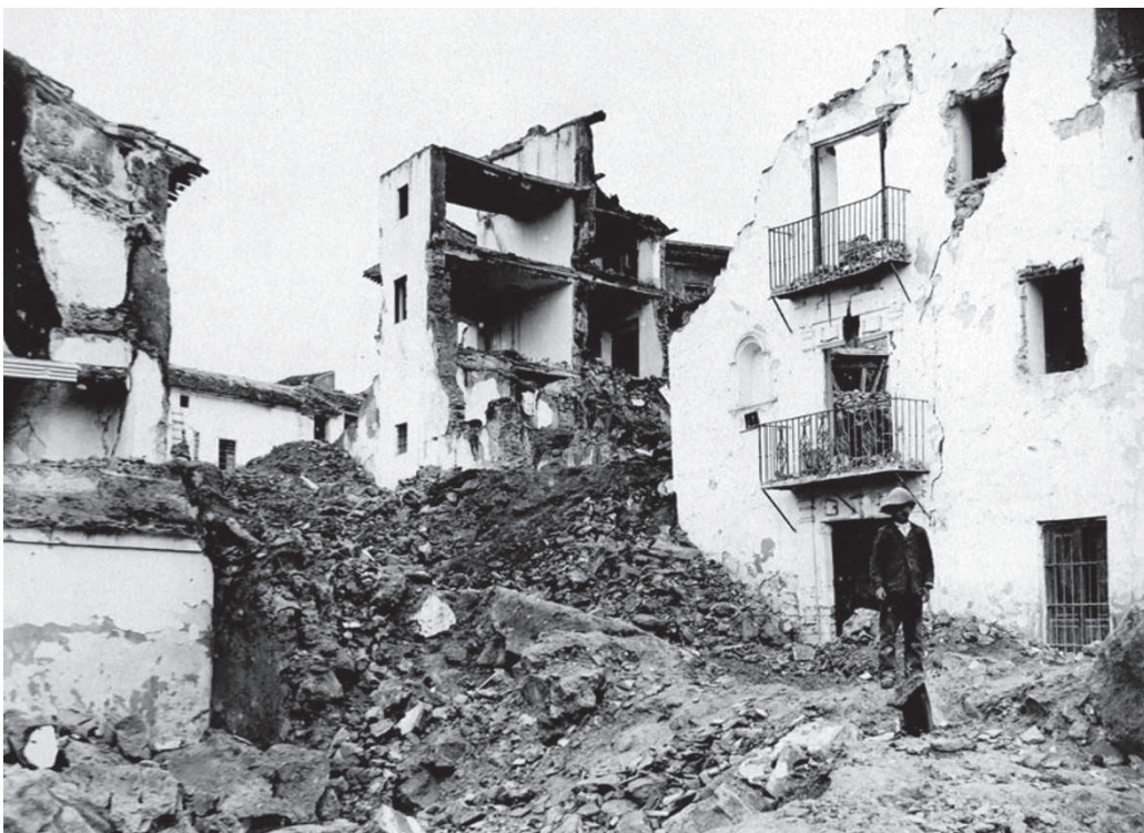
Figura 5. Daños en Alhama de Granada, el pueblo con mayor número de víctimas. Ruinas de las casas junto al tajo y destrozos en una de las calles. Obsérvese como las construcciones de más de dos plantas sufrieron los peores daños.
