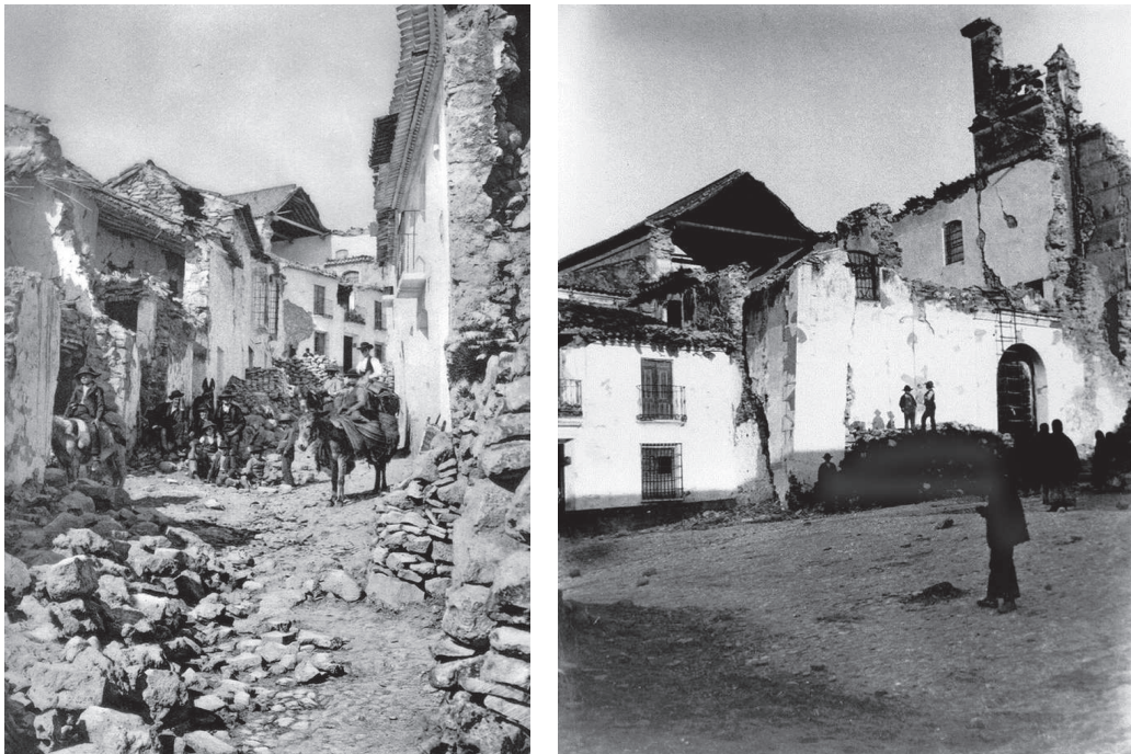
Figura 7. Daños en Periana el pueblo más dañado de la provincia de Málaga. Daños en una calle y en la iglesia.
