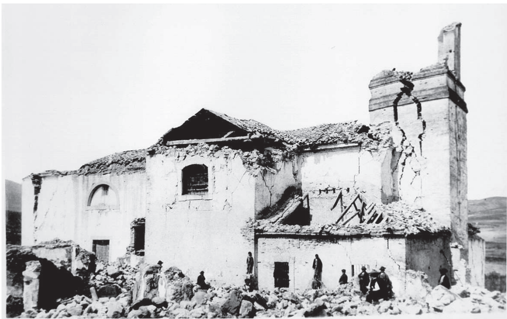
Figura 4. Daños en Arenas del Rey, el pueblo con mayores daños. Plaza del pueblo e iglesia.
