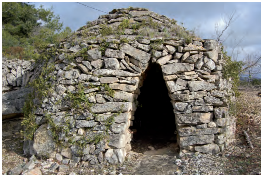
Cabana al Priorat (N. Borrell)
