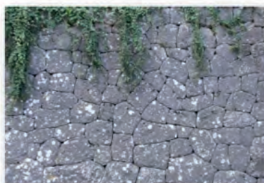
Paret pedra encaixada (sense falques)
