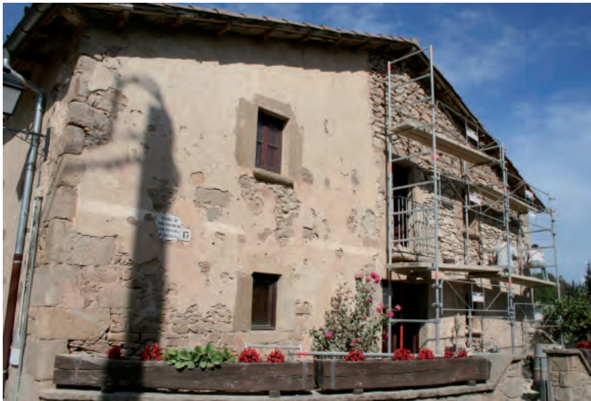
Sora. Bisaura. Destrucció metòdica dels morters de calç a les cases pageses (S. Llagostera)
