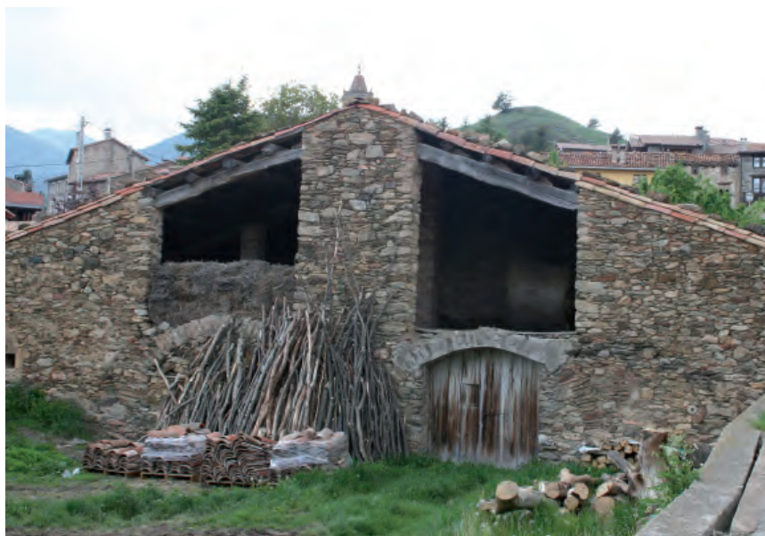
Pallissa a Campelles. Grans obertures, sense barbacana ni morter, a la paret (S. Llagostera)
