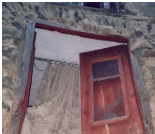
Llanars. Can Xori. Aplicació de la sang de bou amb llet a la fusteria (S. Llagostera)
