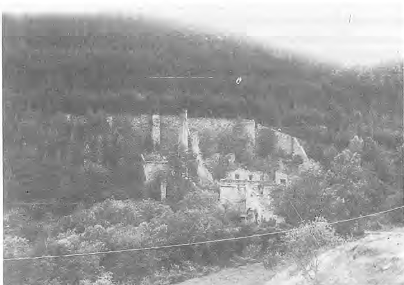
Ruïnes de la que fou "fàbrica" Balagué, encimbellada al muntanyam de Surroca.
