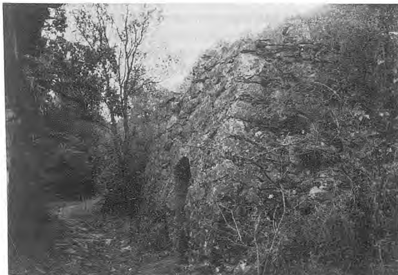
Forn on Coromina calcinà les primeres margues calcàries i n'obtingué ciment romà. Es conserva davant del molí de la Coromina.
