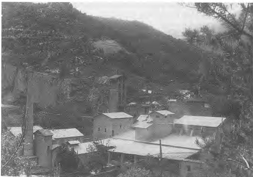
Les "Industrias Benet, S.A.) (I.B.S.A.) a Ogassa, en ple funcionament.
