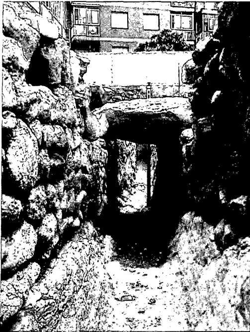
Figura 6. Detall interior del col.lector del c/ Gasòmetre.
