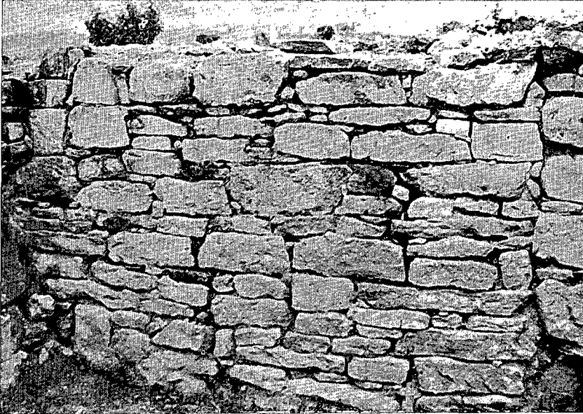
1. Corte L 3. Paramento exterior en la calle transversal. Altura conservada: 1'70 m. Décima campaña 1959-1960.
