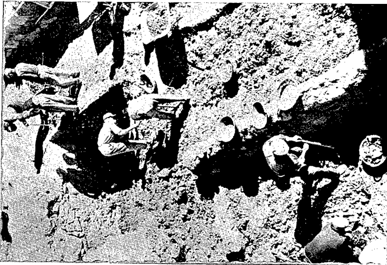
2. Excavación de las dependencias inferiores de los cortes interiores Frigoleta núms. 1 y 2.
