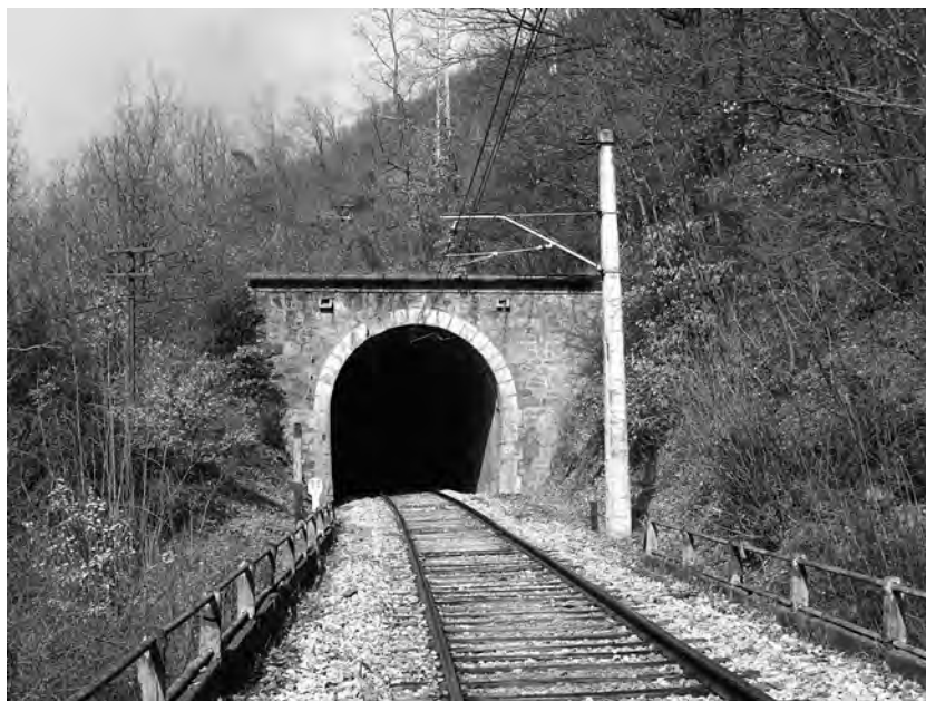
Els túnels del ferrocarril, entre Planoles i la Molina, constituïen punts sensibles que calia protegir a càrrec de la Guàrdia Civil.
