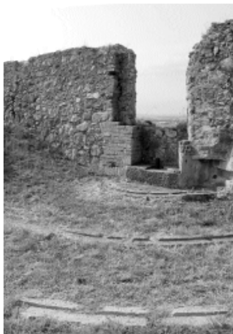
Figura 4. Fotografia d'esplanada per a canó de 14 cm, situada a la cara sud-oest del baluard de Santa Bàrbara. Construïda a finals del segle XIX.
