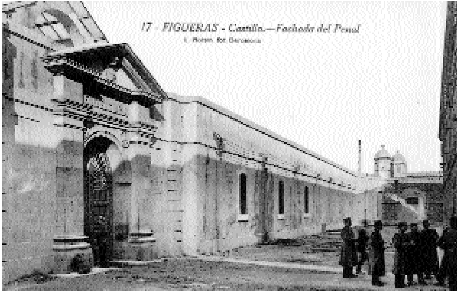
Figura 5. Façana principal del Penal.
