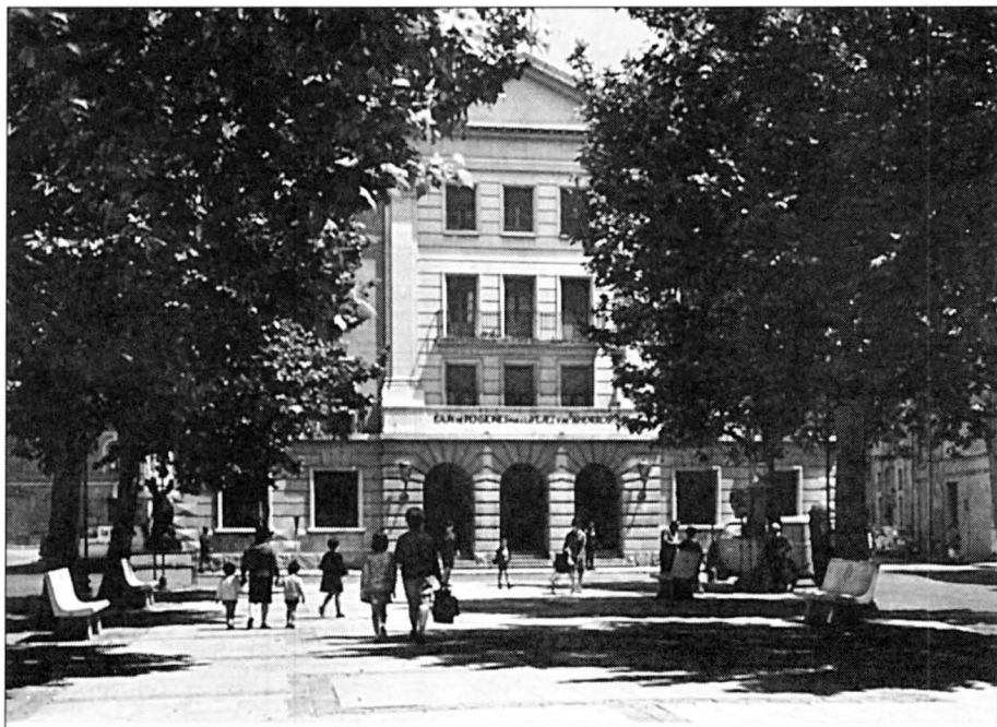
L'edifici de "la Caixa" a la plaça de la Palmera. Encara no hi havia el brollador.
