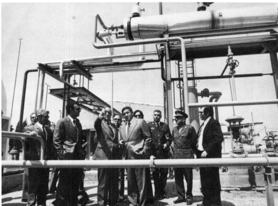
Inauguració de la nova fàbrica.
