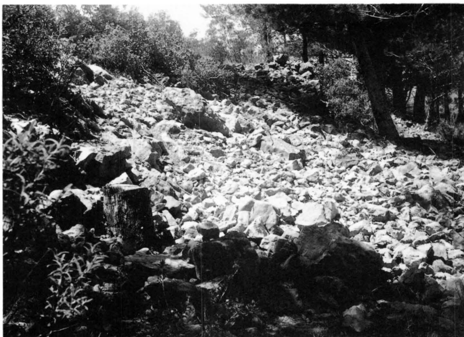
Efecte de les canonades a un parapet en les proximitats del Roure. Observi's al fons les restes que encara s'aguanten.
