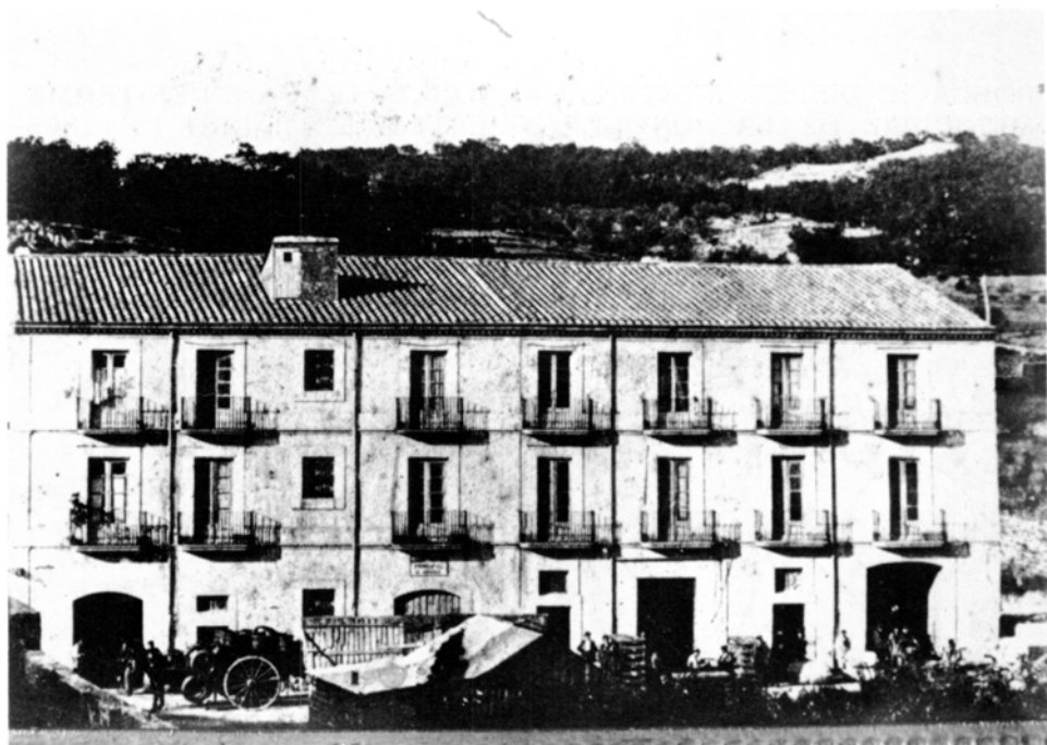
Edifici de l'actual «Unió Jonquerenca» on pot distingir-se encara el rètol que diu «Administración principal de Aduanas».
