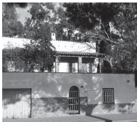
Casa Espigulé, façana frontal a la carretera del far. Roses. 1946.
