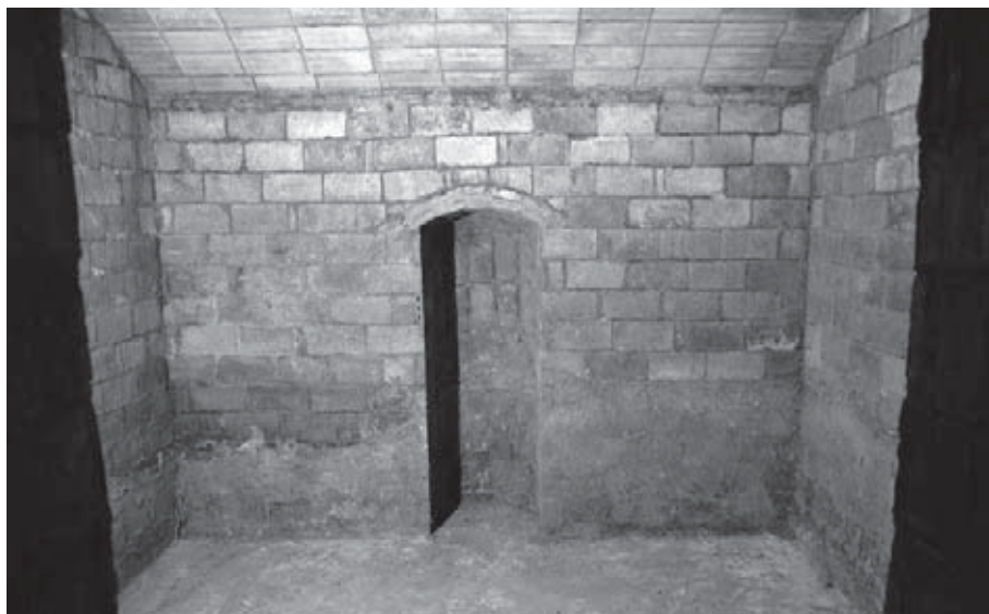
Figura 11. Armariet obert en el mur nord de la sala de la farmaciola.
