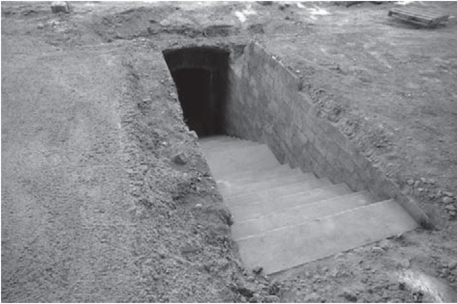
Figura 12. Escales de l'accés del costat oest del refugi.
