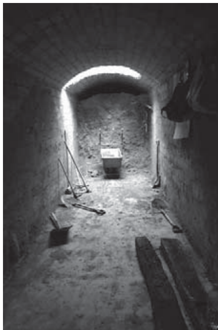
Figura 6. Procés de desenrunament de la galeria principal, que es veu plena de terra fins pràcticament dalt de la volta.
