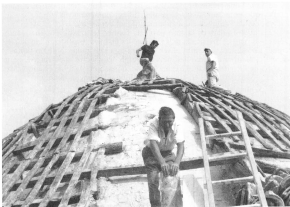
Entramat de cairats i llates que sostenien i donaven forma al teulat de la cúpula. Foto Pinadell.
