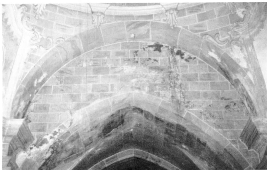
Connexió de la volta de la nau i l'arcada del creuer, on abans hi havia l'absis romànic.
