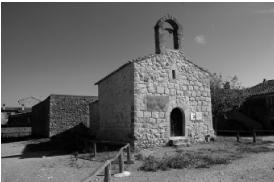
Aspecte actual de la capella de Santa Reparada de Cinclaus, una vegada finalitzada la seva excavació i restauració.
