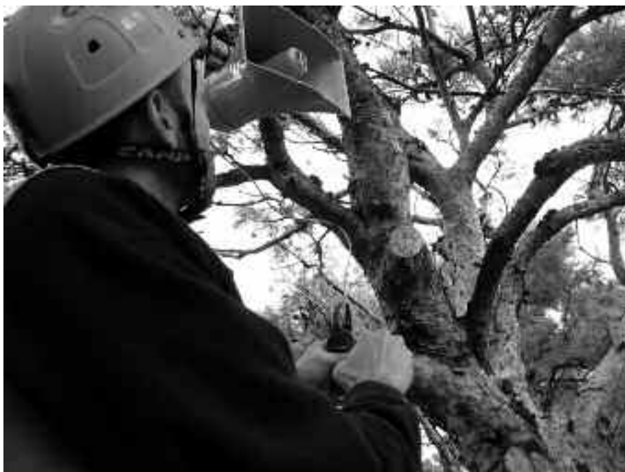
Instal·lació dels altaveus als pins del parc Bosc.
