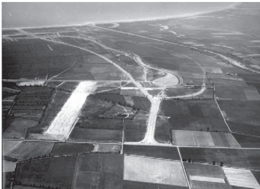
Vista aèria dels primers moviments de terres. A la dreta el riu Muga, al fons el mar i en primer pla la carretera de Roses a Figueres, l'aeròdrom, l'accés principal i els vials. 1965. AMCE. Col·lecció Dolors Parnau. Paisajes españoles.
