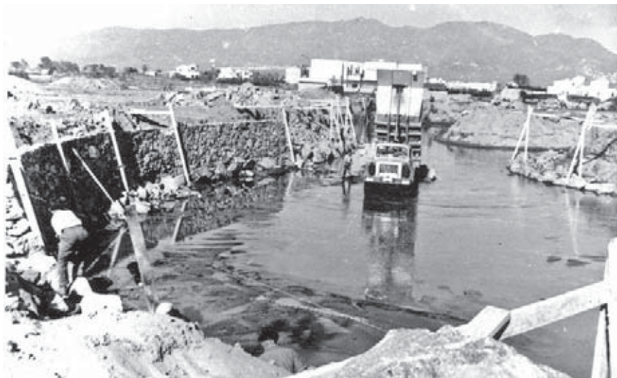
Construint un canal. AMCE. Col·lecció Miquel Arpa Batlle, núm. 9202.
