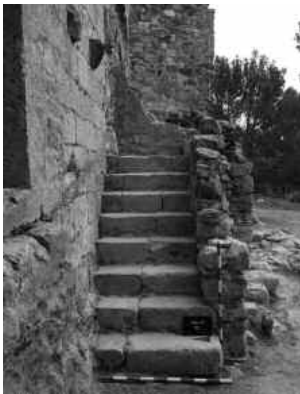
Figura 8. Detall de les escales que portaven al segon pis. Zona 2 - sector 2.
