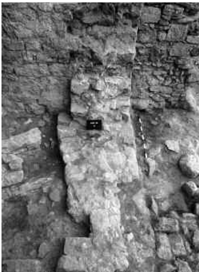
Figura 7. Detall del mur sud del transsepte meridional.
