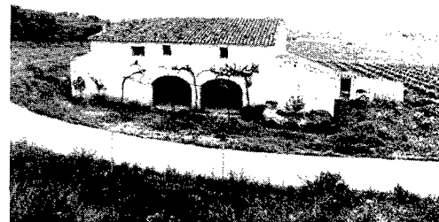
Figura núm. 9: Casa rural aïllada a Benissa. L'espai filtrant ja ha estat incorporat al volum únic de la casa.
