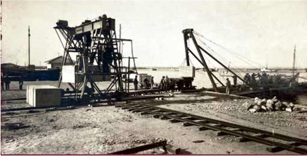
Transport de blocs per a reforç del Moll de Costa. S'observa en primer pla la via que donava servei al citat moll encara sense guarnir. Fot. Col·lecció de l'autor.
