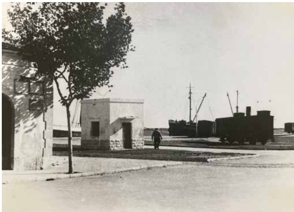
D'esquerra a dreta, l'edifici de salvament de naufrags (actualment la Creu Roja), via d'accés al Moll de Costa, bàscula de pesatge de camions i vagons tipus K de la companyia del Nord. Doc. Arxiu/col·lecció Autor.
