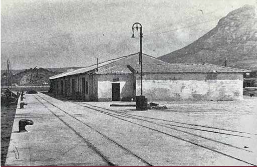
Les imatges de les instal·lacions fèrries del port de Dénia en conjunt no són molt habituals. En aquesta i d'esquerra a dreta. Segona via construïda en el Moll d'Atracada, primera via i la seua prolongació feia el Moll de Costa, que tancaria amb el pas del temps el triangle format per les dues vies provinents de l'Estació del Nord. Font: El Puerto de Dénia una ilusión de progreso.
