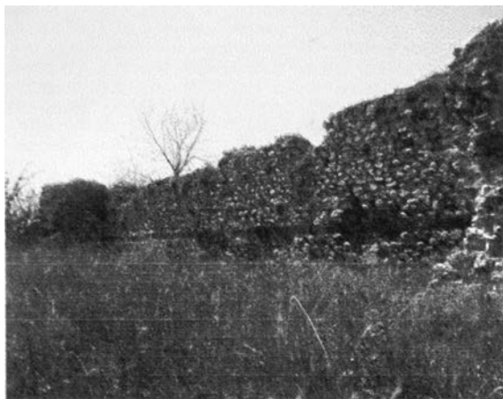
Mur occidental de l'estació viària de Petropigí.
