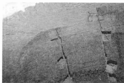
Foto 3: Interior de la cisterna. S'observa la volta de maó que la cobreix amb els catúfols i, a la part inferior, el banc de paret seca.
