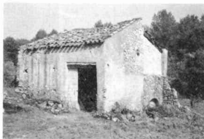
Foto 2: Caseta que cobreix la Sínia. En el subsòl hi ha la cisterna on acaba el qānat.
