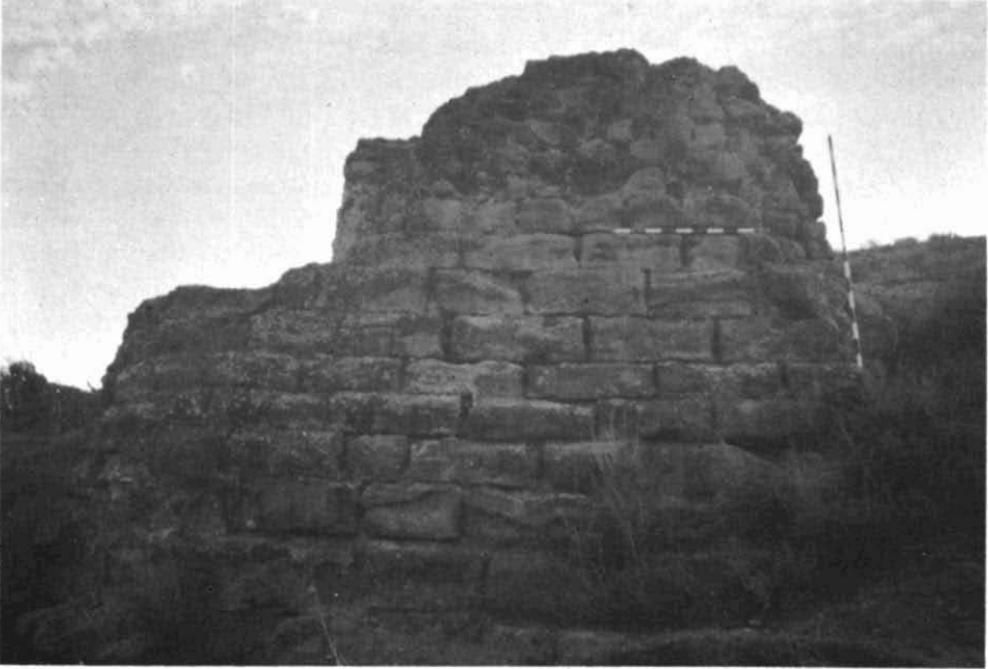
Foto 1. Cara nord de la torre del castell d'Albesa.
