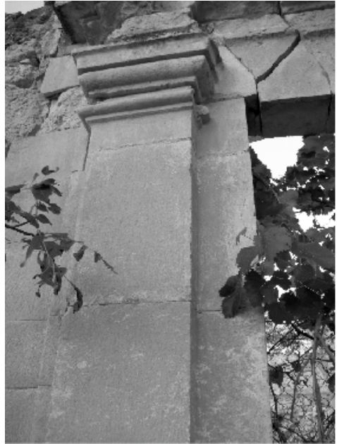
Detalle de pilastra. Portada de la iglesia del convento franciscano de San Guillén. Castielfabib. Foto del autor.
