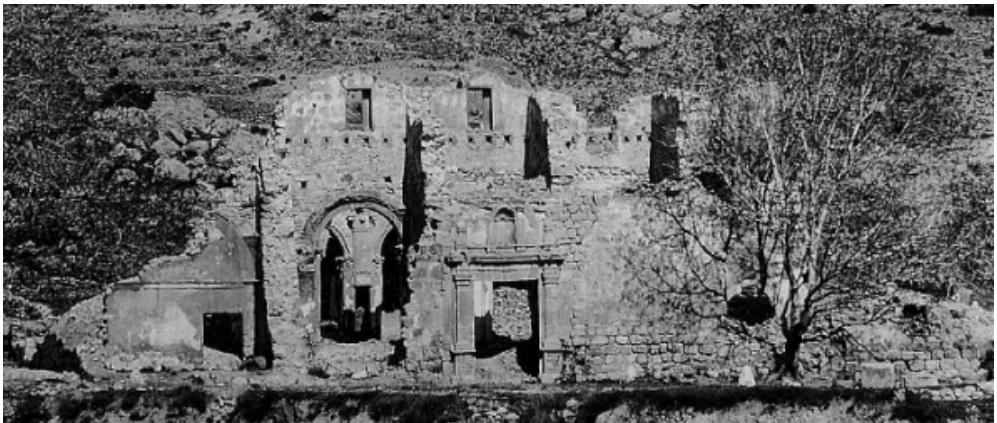
Detalle de las ruinas de la iglesia del convento franciscano de San Guillén de Castielfabib en el año 1917. Foto Arxiu Amatller.
