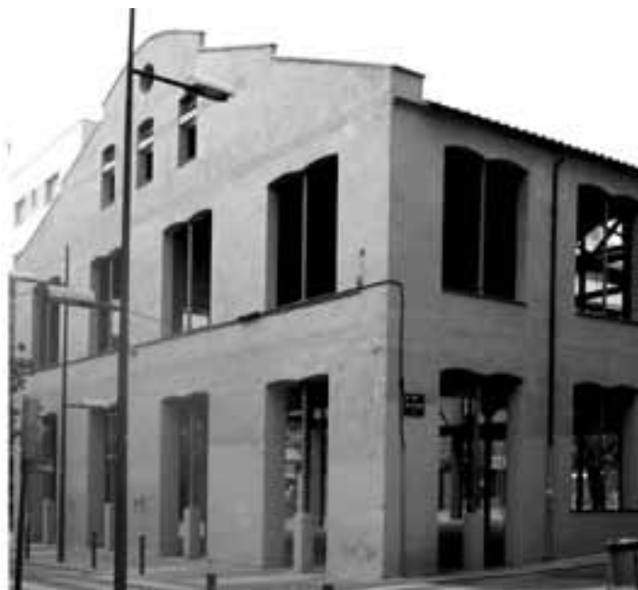
3. Imatge actual de la façana de la quadra corresponent, única supervivent del complex.
