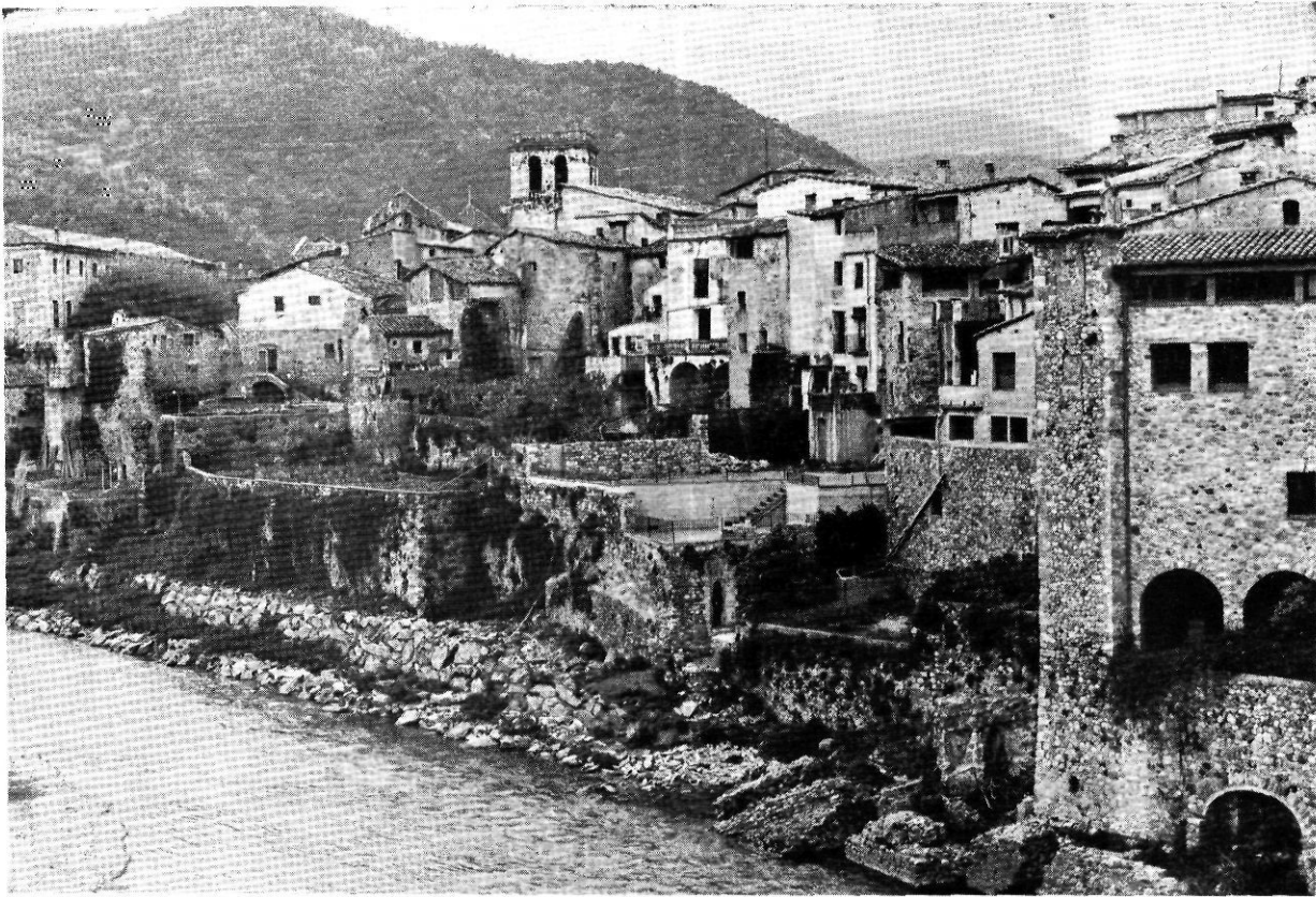
Fig. 8. - Panoràmica, des del pont medieval, del sector de Besalú on està ubicada la miqwé.
