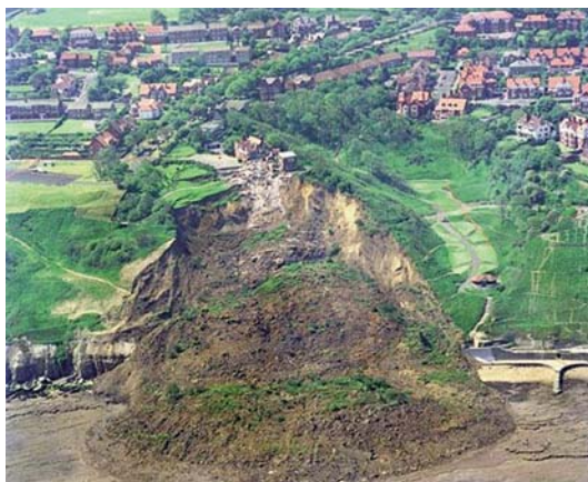
Fig. 6: Deslizamiento rotacional de Holbeck al sur de Scarborough (UK) en 1993. Afectó a un hotel pero no hubo víctimas mortales porque los huéspedes fueron desalojados con anterioridad. (Por cortesía del Servicio Geológico Británico http://www.bgs.ac.uk/landslides/holbeckHall.html ).
