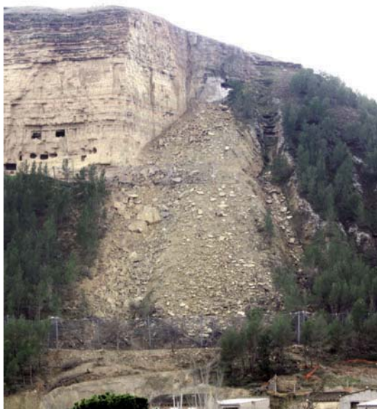
Fig. 17: Desprendimiento de rocas que afectó unos almacenes en la población de Ballobar (Aragón).
