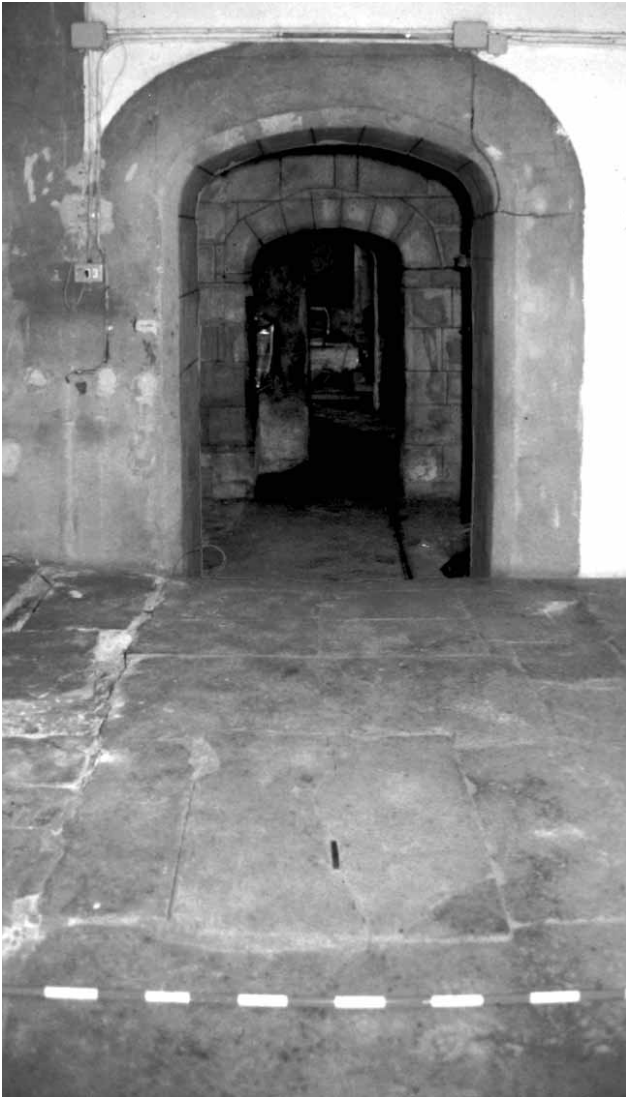
9. Enterrament 1 abans de l'excavació
