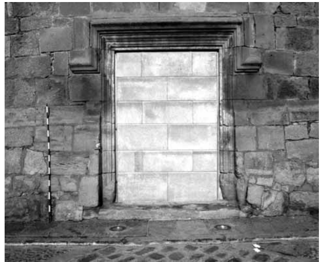
40. Façana sud de l'església amb la porta tapiada darrera de la qual hi ha la sitja 1.
