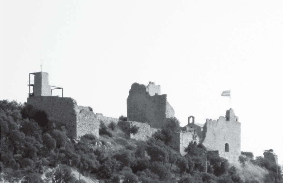
El castell enrunat de Palafolls des de l'oest. Fou residència d'un casal descendent dels senyors del Montseny que plantà cara a l'hegemonia dels vescomtes de Cabrera fins a les darreries del segle XIV (Foto: autor).
