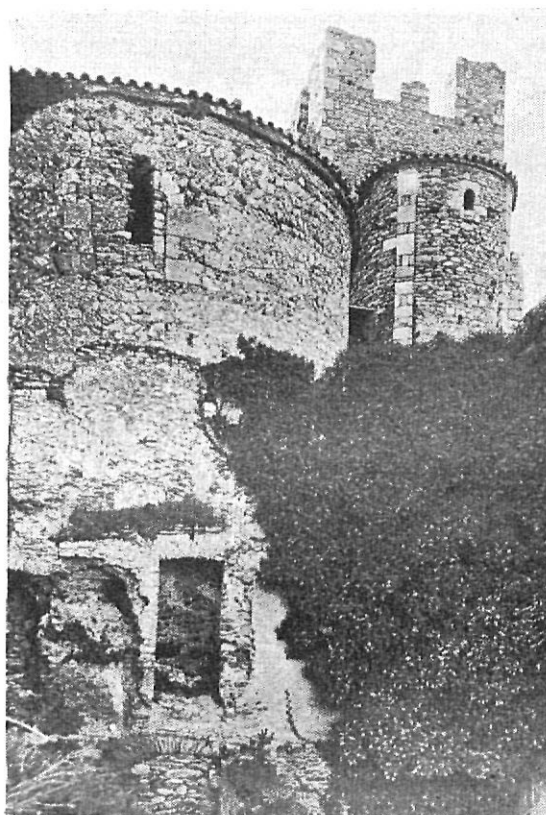
Detalle de la cabecera. Nótese los diversos aparejos del ábside central de la intrínseca capilla (tercera en altura) del lateral, hecho con mampostería y contrafuerte, diverso a su vez de la torre del fondo. (Fig. 20)
