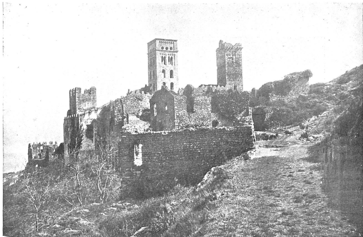
Vista de conjunto; compárese los tipos arquitectónicos y el aparejo de la capilla en primer término, primitiva, y la torre románica de tipo lombardo catalán.
