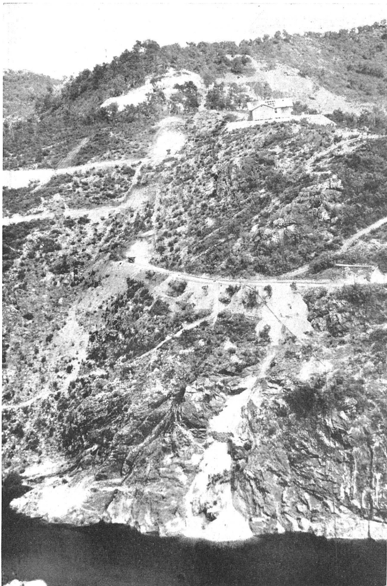
Margen izquierda del Muga con las excavaciones del estribo izquierdo de la presa de Buadella ya iniciadas.
