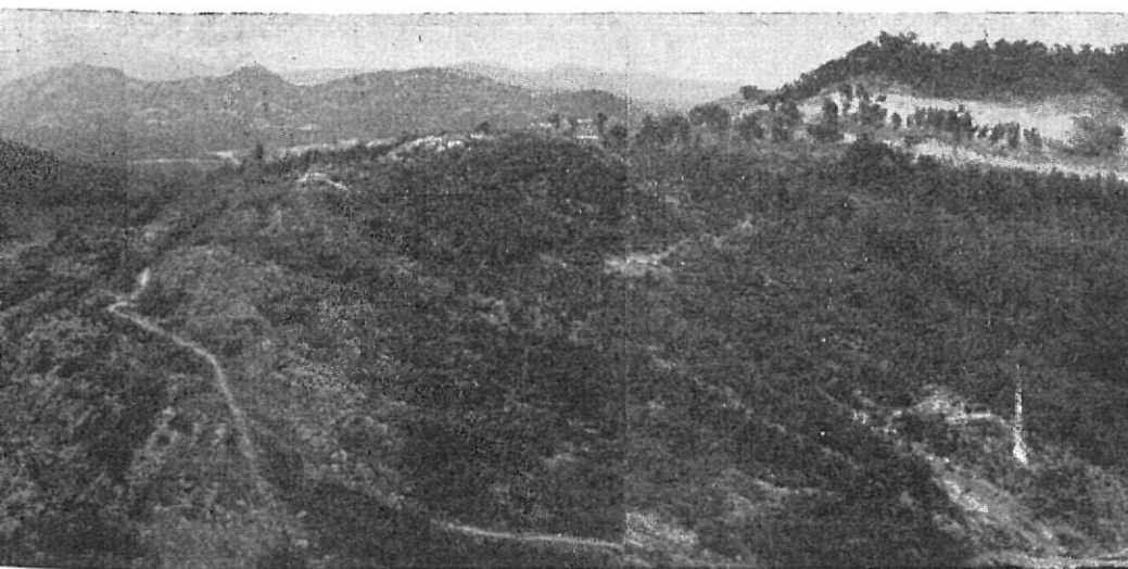
ones ya iniciadas. Al fondo la ataguia a punto de cerrar el río dirigiéndolo hacia el túnel de desviación.
