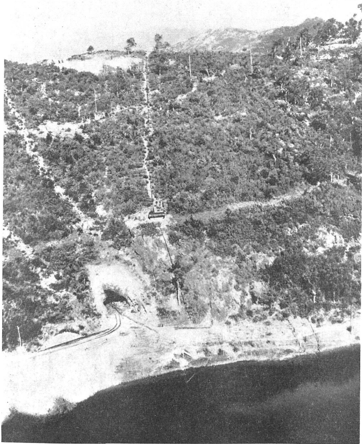
Margen izquierda del Muga aguas abajo de la ubicación de la presa de Buadella, con la perforación del tunel de desviación terminada.
