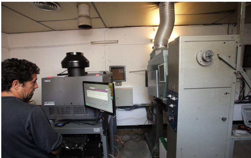
>> Instal·lació del nou projector digital al Cinema Truffaut de Girona.
