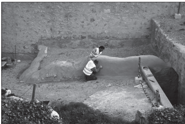
Lámina VI. Estructuras 3 (superior), 9 y 11 durante la intervención: limpieza de los restos del mortero de protección disgregados, cubrición con geotextil, aplicación del nuevo mortero de protección, reposición de la grava de color rojo –fase andalusí almohade, siglos XII-XIII–, y colocación de la grava de color negra –fase andalusí taifal, siglo XI–, rojo –fase andalusí almohade, siglos XII-XIII–, ocre –fase cristiana bajomedieval, siglos XIV-XV–, y gris –fase cristiana moderna, siglo XVI.
