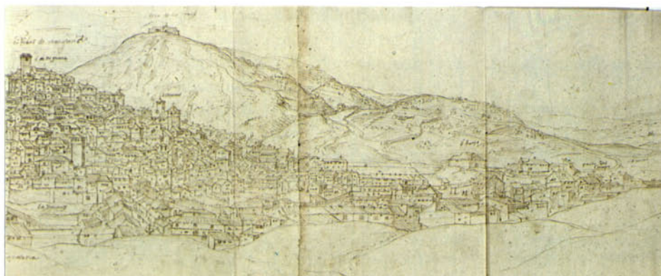
Foto 10: La ciutat de Cuenca. Durant el segle XVI fou cap d'un dels districtes ramaders de la Meseta. En la imatge una visió de la ciutat emmurallada. S'hi distingeix la Catedral, convents i edificis nobles. En primer terme el riu Xúquer i el pont que comunica la ciutat amb un nucli habitat on s'hi troba el gran edifici de Santa Maria del Puente i els convents de San Antonio i San Lorenzo. ( Department of Prints and Drawings and Paintings, Victoria and Albert Museum, Londres )
