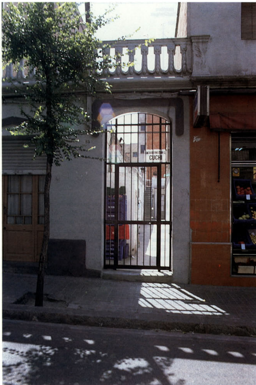
Foto 3: Carrer de Mas núm. 85. Passeig lateral amb cinc habitatges. El primer amb entrada pel carrer
