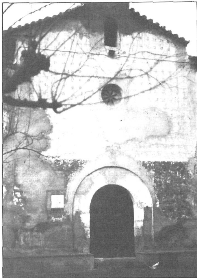
Façana de St. Llorenç. Estat actual (vista parcial) (Foto: X. Salat)
