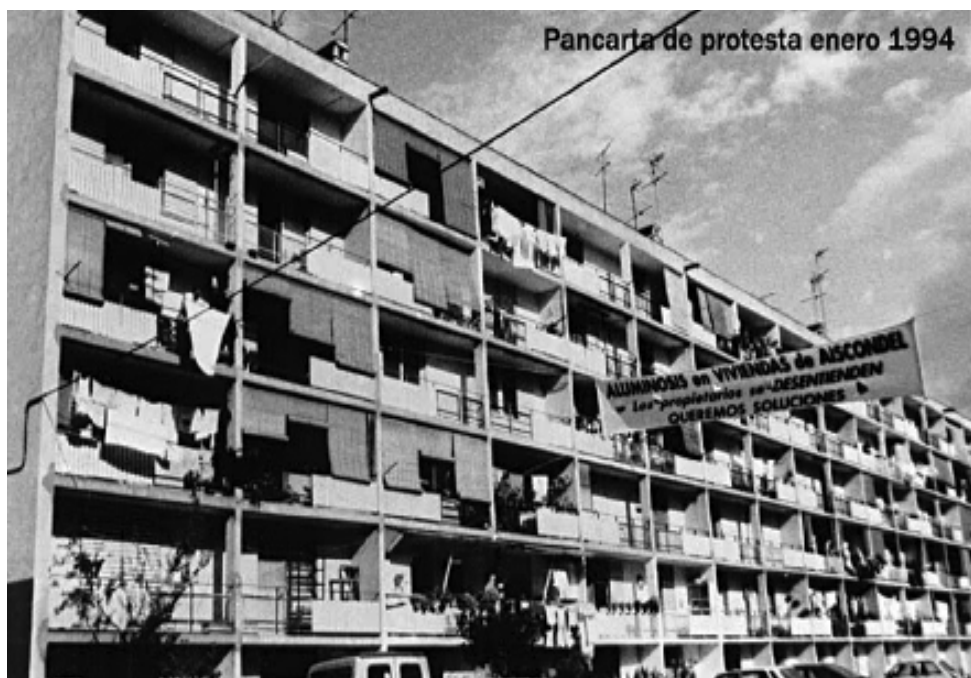
Bloc de pisos de Cerdanyola construïts l'any 1956 i enderrocats, pels greus problemes de construcció, l'any 1995. Els blocs Ciutat Comtal van ser projectats seguint la seva imatge (Blog personal de José Rodríguez Urbano)
