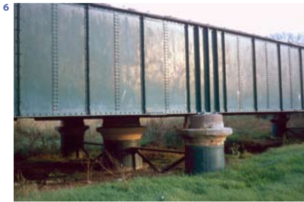
6 El nou aqüeducte és una peça esplèndida, configurada com una gran biga-calaix amb una elegant estructura d'acer.
